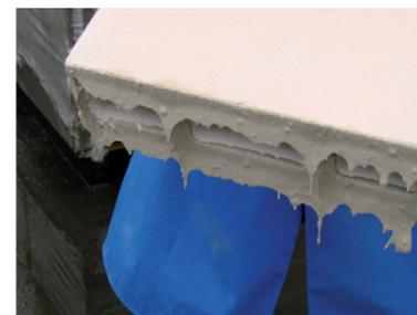
Die UNIKA Bauplatten werden in den Mörtel getaucht, so dass die Steinunterseite vollflächig damit behaftet ist.
