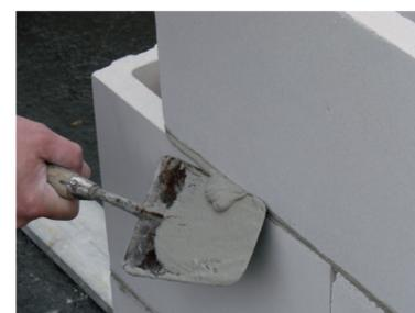
Nach dem Versetzen der Bauplatte wird der ausquellende Dünnbettmörtel mit der Maurerkelle glatt abgezogen. Die fertige Lagerfugendicke sollte 2 mm betragen.
