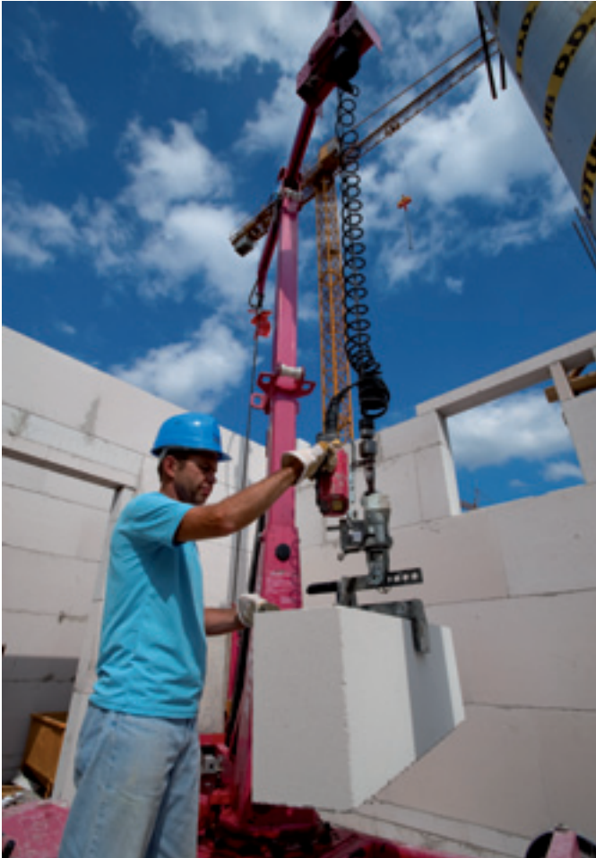
UNIKA Fertigteilsturz zur schnellen und rationellen Öffnungsüberdeckung
