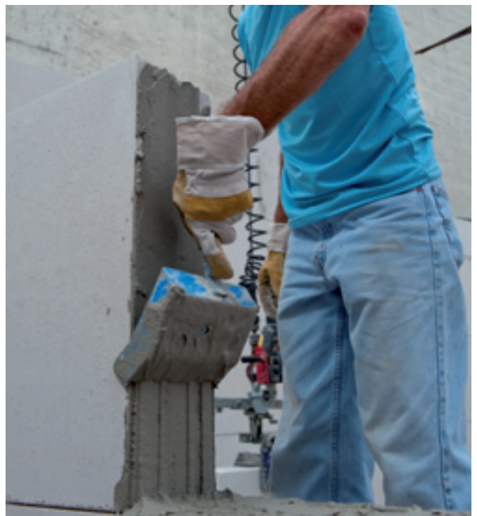
Auftragen von Dünnbettmörtel mit einer Zahnkelle
