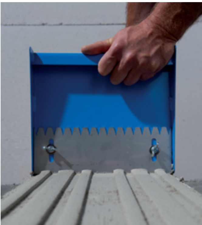
Mörtel mit Mörtelschlitten aufziehen
