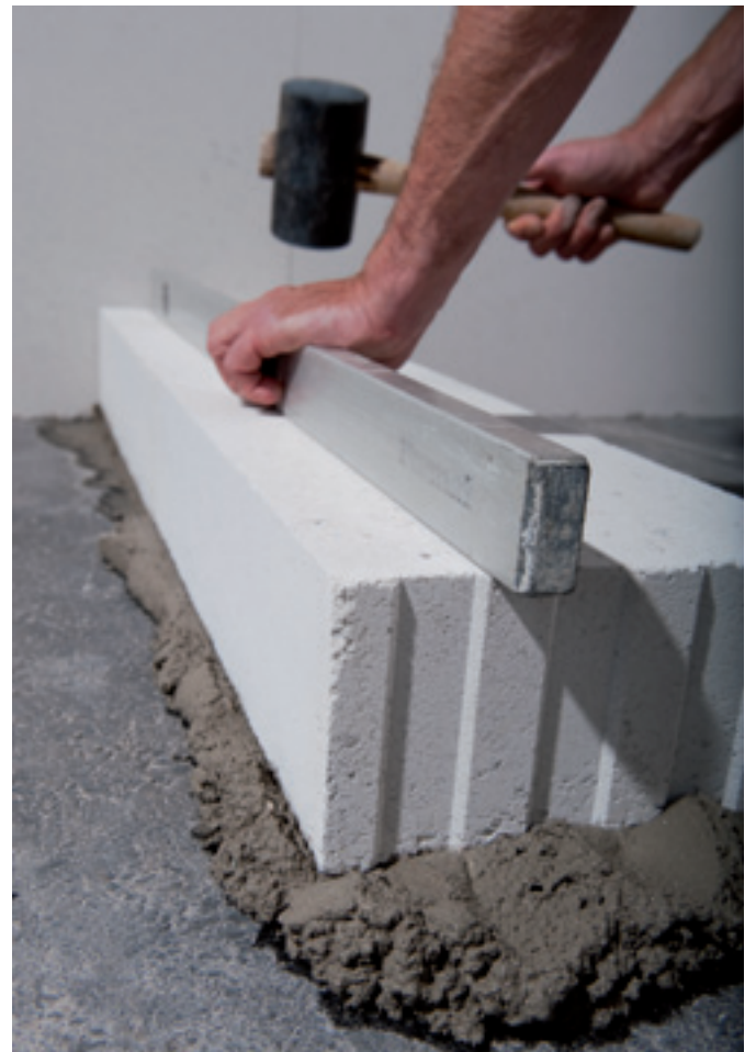
Ausrichten der UNIKA Kimmsteine
