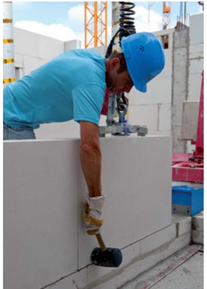
Nachjustieren mit Gummihammer
