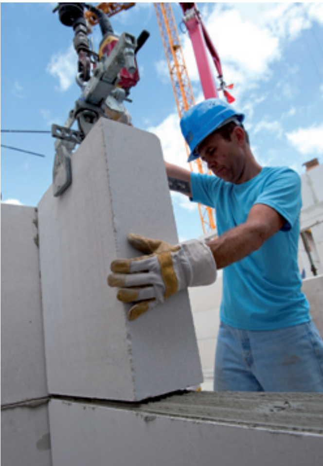
UNIKA Planelement absetzen
