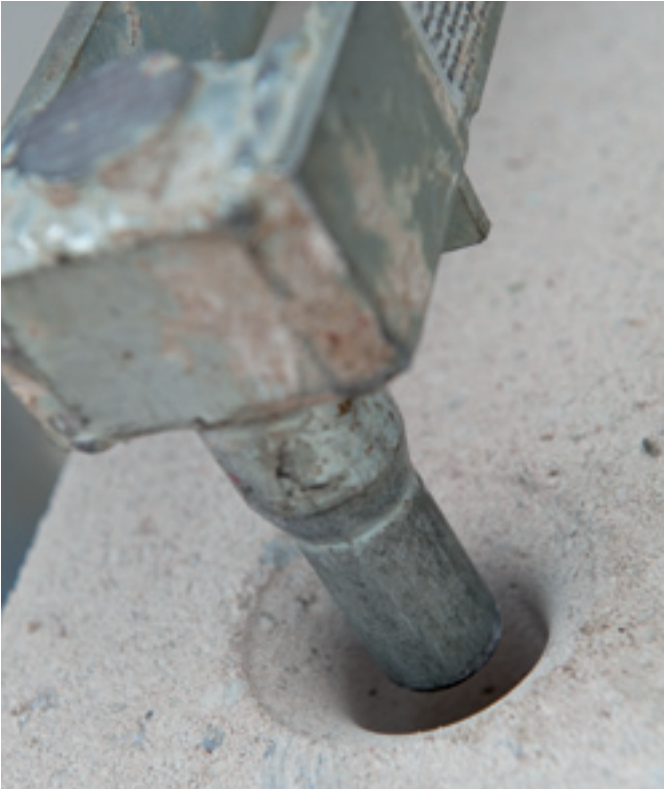
Hantierlöcher für die Versetzzange
