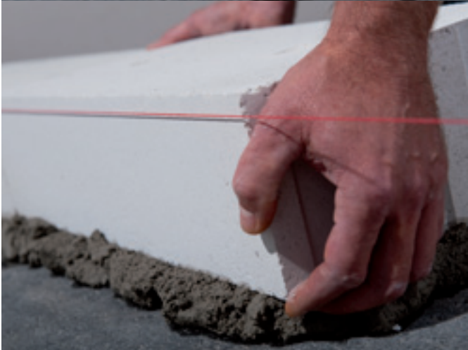
Verlegen der UNIKA Kimmsteine im Mörtelbett
