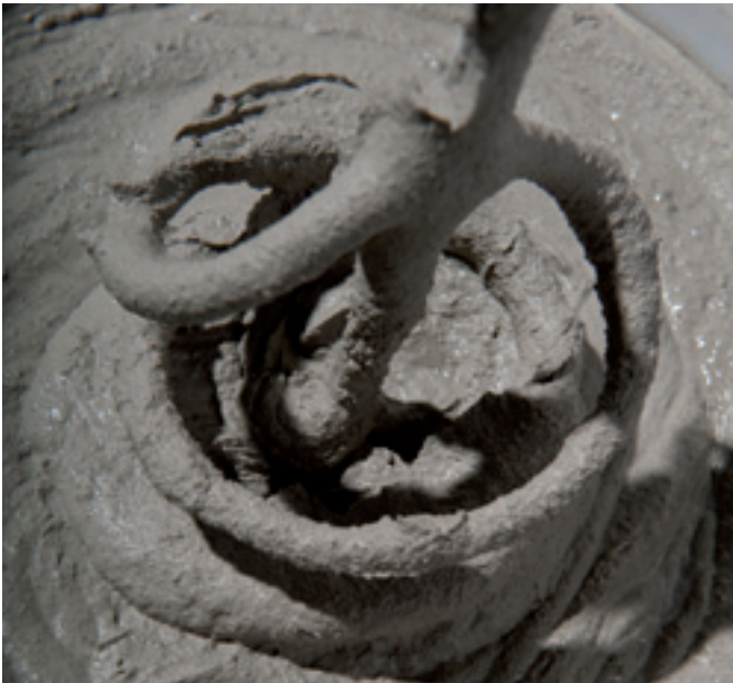
Mörtel nach Herstellerangaben mischen
