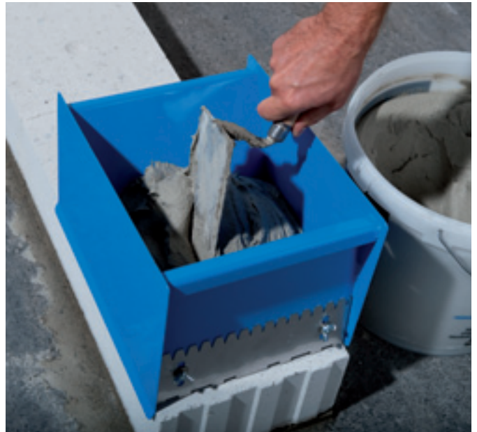
Dünnbettmörtel in Mörtelschlitten füllen
