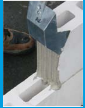
In wenigen Fällen notwendig: Die Vermörtelung der Stoßfuge
