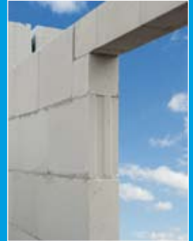
Sturzausführung mit Höhenausgleichsstein
