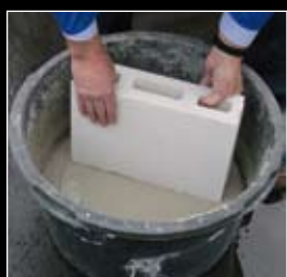
... findet bei der Vermauerung der UNIKA KS-Bauplatte als Tauchmörtel Verwendung
