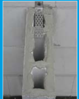
Konstruktive Anbindung der UNIKA KS-BP 10 an bestehende Wände mit WandanschlußBankern
