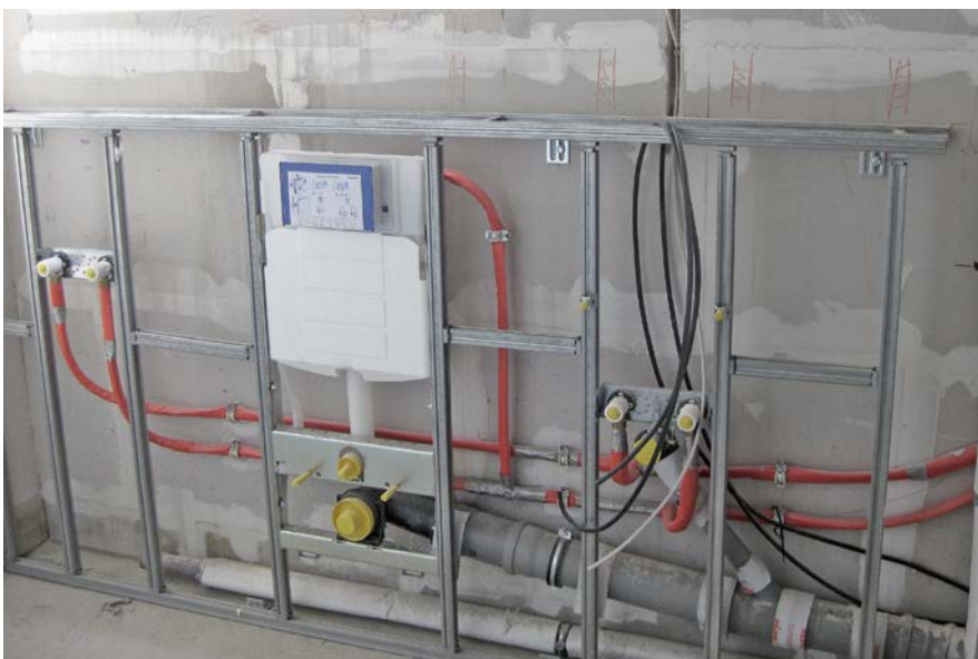
Bild 35 Vorwandinstallation mit verspachtelten Mauerwerksfugen
