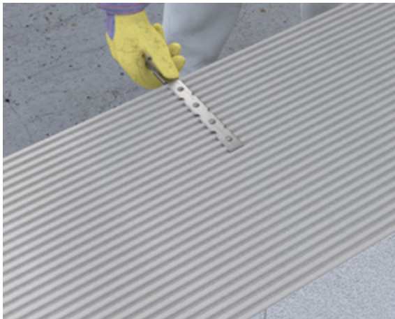
Abb. 10.11: Einlegen eines Mauerankers zur Erstellung einer zug- und druckfesten Verbindung von Porenbetonwänden (Stumpfstoßtechnik)
