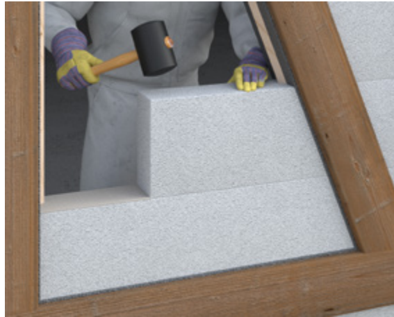
Abb. 10.27: Ausmauerung von Holzfachwerk mit Porenbeton
