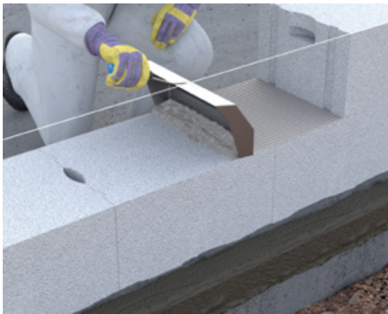
Abb. 10.7: Auftrag des Dünnbettmörtels auf der Lagerfuge einer Steinschicht mit Plansteinkelle
