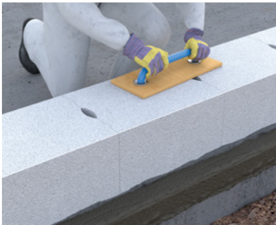
Abb. 10.6: Beseitigen von ausführungsbedingten Unebenheiten mit einem Schleifbrett
