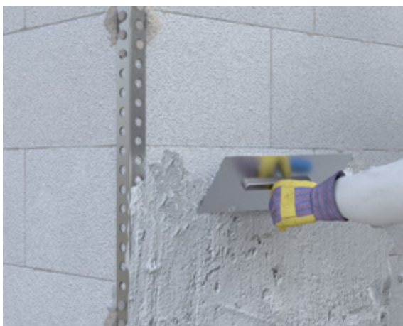
Abb. 10.24: Einlagiger Leichtputz als Außenputz auf Porenbetonmauerwerk – manuelles Aufbringen der ersten Schicht
