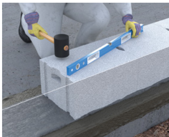
Abb. 10.5: Versetzen der Porenbeton-Plansteine und Ausrichten mit Gummihammer
