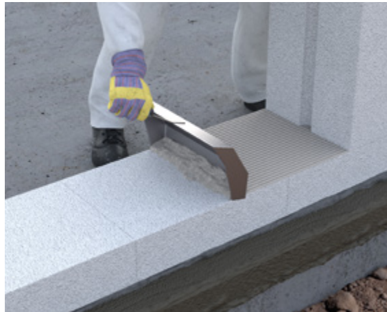
Abb. 10.14: Auftrag des Dünnbettmörtels mit einer Plansteinkelle auf Höhenausgleichsschicht (Kimmschicht) für darüber aufgehendes Mauerwerk aus Porenbeton-Planelementen
