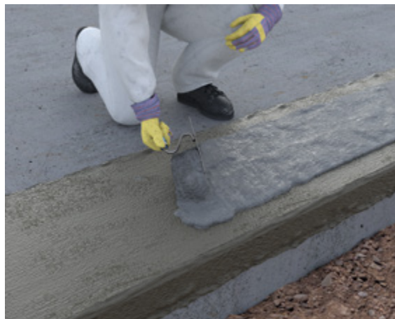
Abb. 10.4: Auftragen des Mörtelbettes der Mörtelgruppe III in Steinbreite auf der mineralischen Dichtungsschlämme
