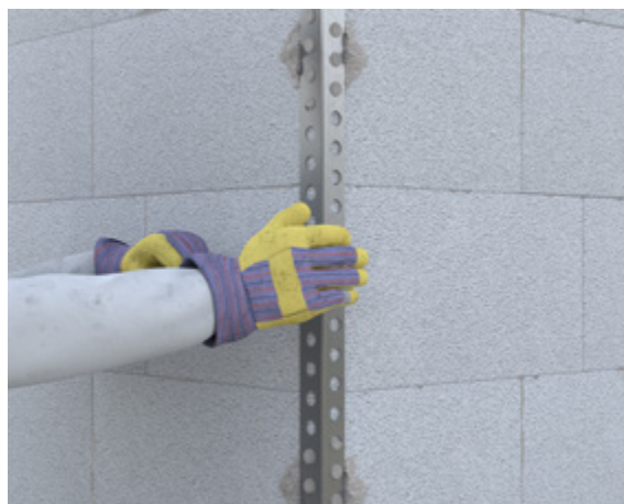
Abb. 10.23: Sicherung der senkrechten Gebäudekanten durch Eckschutzprofile
